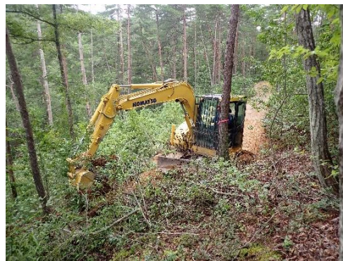
作業道の作設
