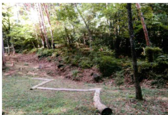
▲整備前 危険木等伐倒 (飯田市)
