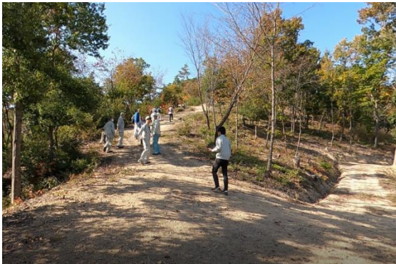
里山公園までの遊歩道を整備 伐採木を活用した階段も設置されている
