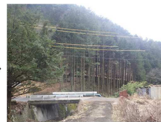
県管理河川の除間伐 (上松町 一級河川中沢)
