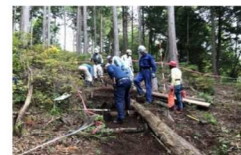
飯島町町民の森傘山: 歩道整備
