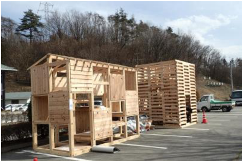
在来工法(左) と組積造(右)でミニチュアハウスを製作
