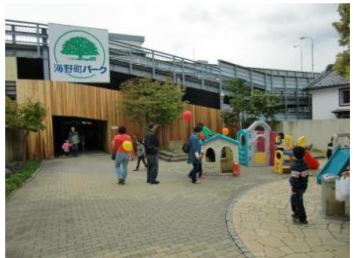
公園と駐車場の間に設置された木塀
