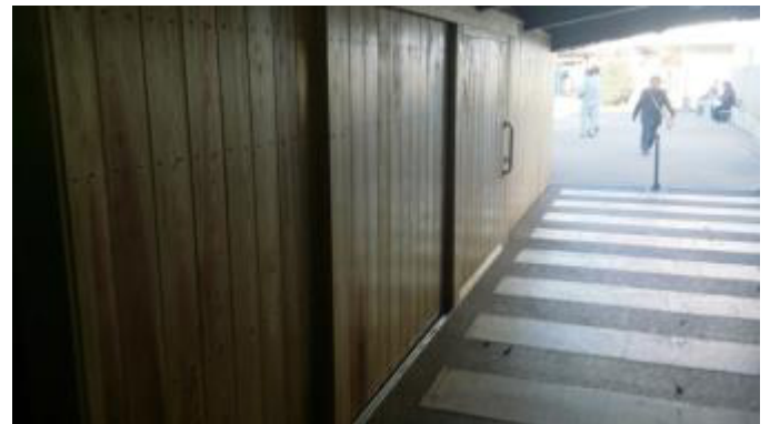
駐車場の連絡通路も木質化
