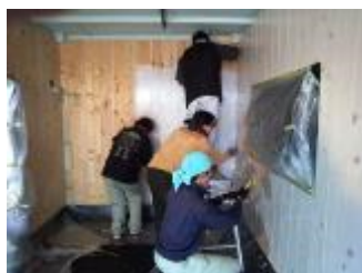
内装木質化の作業
