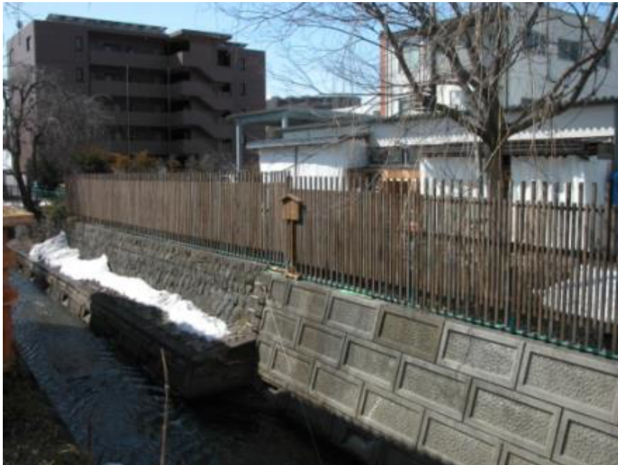
柳町蛭沢川沿いの木製格子フェンス(延長50m)
