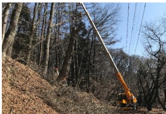
ライフライン沿いの危険木伐採
