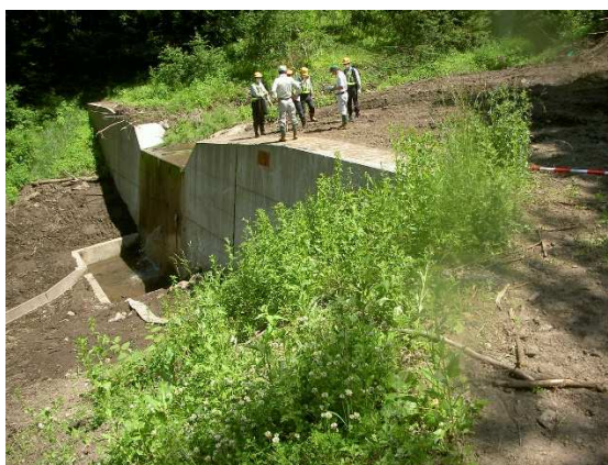
治山ダムの設置状況
