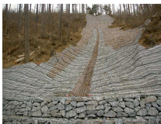
山腹工の設置状況
