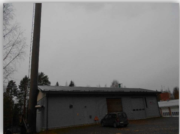
【チップボイラー工場での外観】
