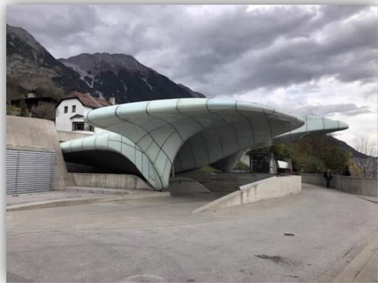
【ロープウェーの駅舎】
