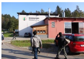
バイオマス地域熱供給プラント
