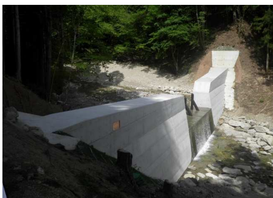
流木捕捉式治山ダムの設置状況
