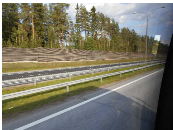
【高速道路の木製遮音壁】
