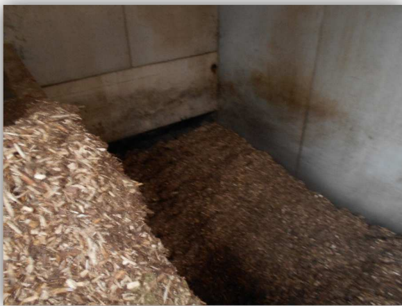
【左上のボイラーへ全自動で必要分を供給】
