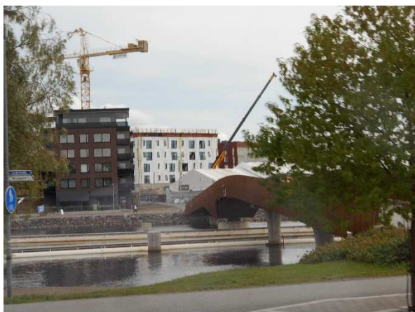
【フィンランドの木造学生寮建築現場】
