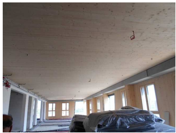
【天井部の CLT】
