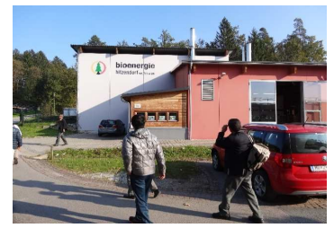
バイオマス地域熱供給プラント
