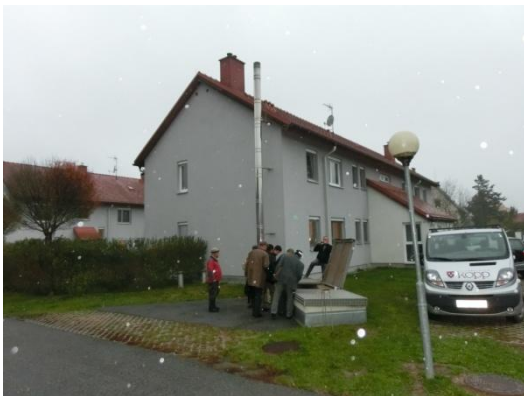
小規模ボイラの入っている集合住宅
