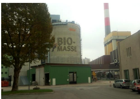
木質バイオマス発電所（チップサイロ）
