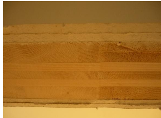
間仕切り壁。断熱材がないため外壁よりも薄い
