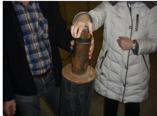
配管のパイプ。水漏れセンサー付き
