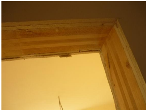
間仕切り壁。断熱材がないため外壁よりも薄い
