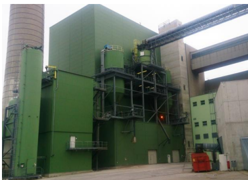
ボイラ棟全景
