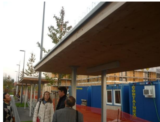
自転車置場の天井も CLT
