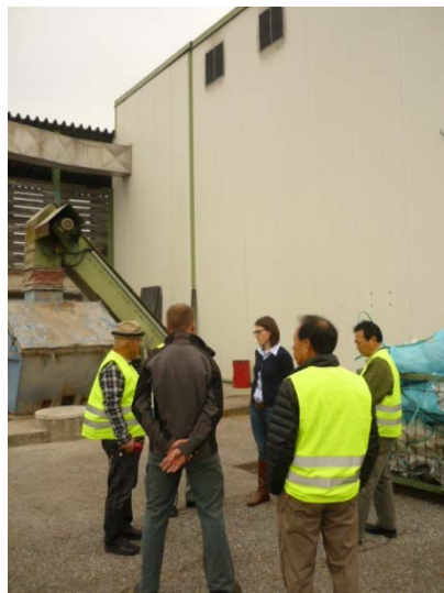
バイオマスボイラー棟
