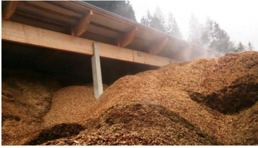
山の斜面を利用した半屋根のチップヤード
