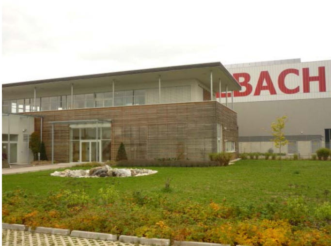
コールバッハ社ボイラー製造工場(ブライブルグ)
