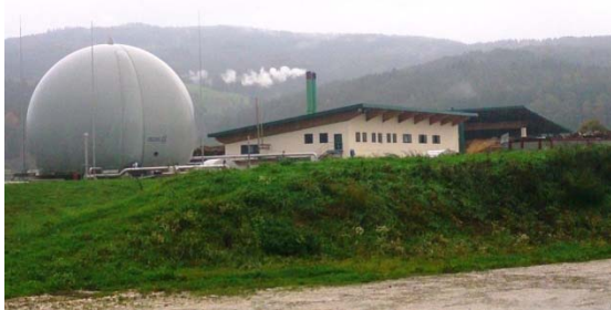
施設遠景 (左はバイオガス貯蔵施設)
