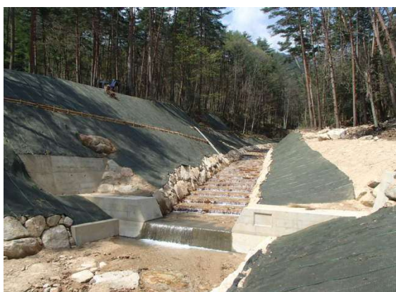
丸太木工沈床と床固工
