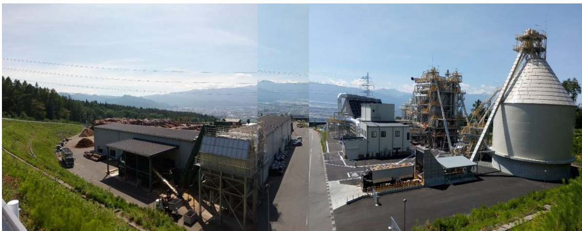
木質バイオマスの発電施設（塩尻市）
