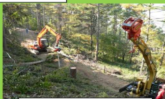
スイングヤーダ木寄せによる架線系システム
