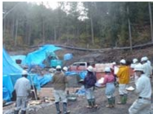
丸太残存型枠の 施工現場見学
