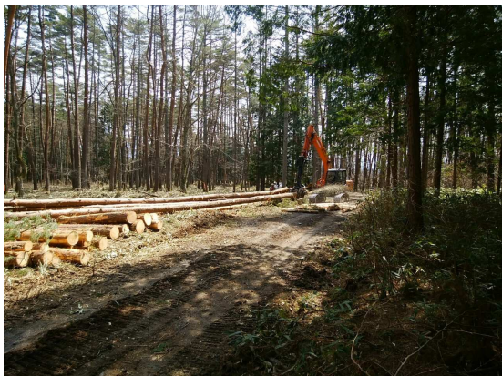
特殊地拵作業状況（アカマツの搬出）
