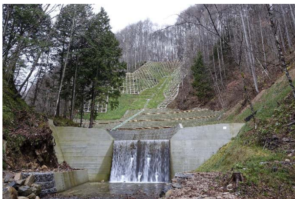
荒廃地の復旧状況
