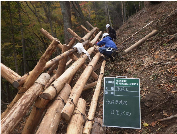
【①防護柵施工状況】
