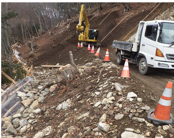
【③掘削工状況（谷側への土砂流出防止状況）】
