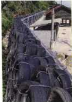
当初施設の完成状況
