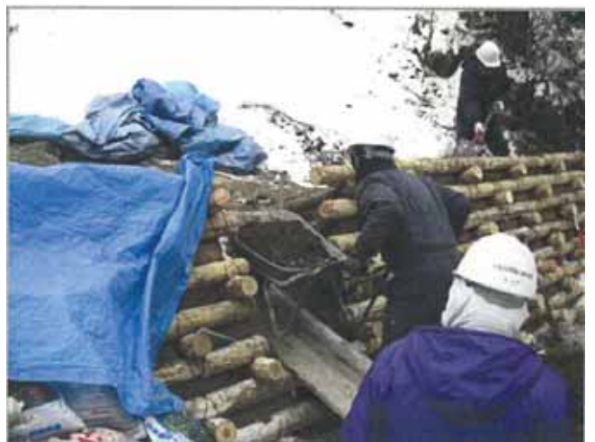
背面盛土状況
