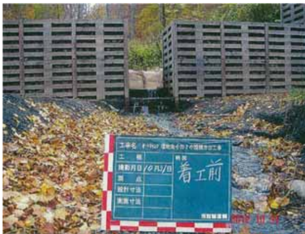
《対策実施前（平成 23 年設置後）》
