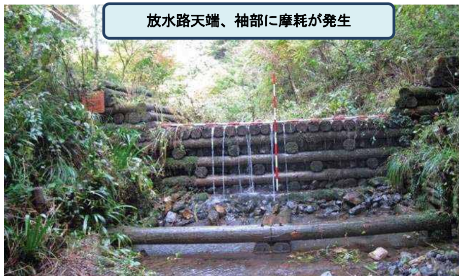
《対策実施前（損傷状況）》
