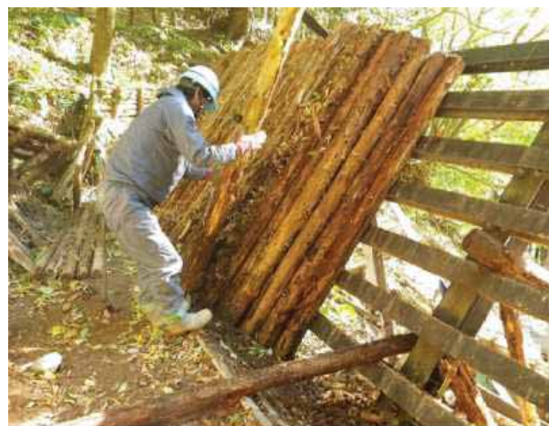
《施工状況（撤去）》
