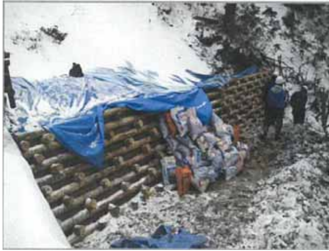
前面部施工状況
