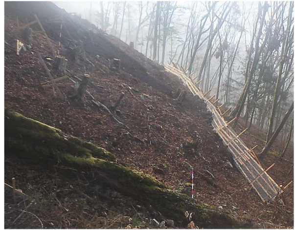
【②防護柵設置完了】
