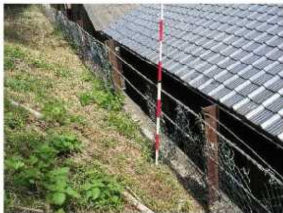
当初施設の完成状況
