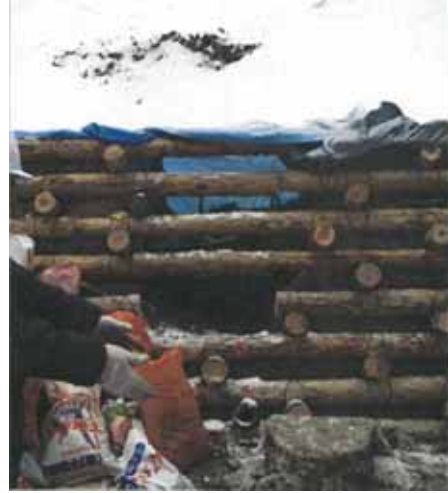
水路工吐口部施工状況
