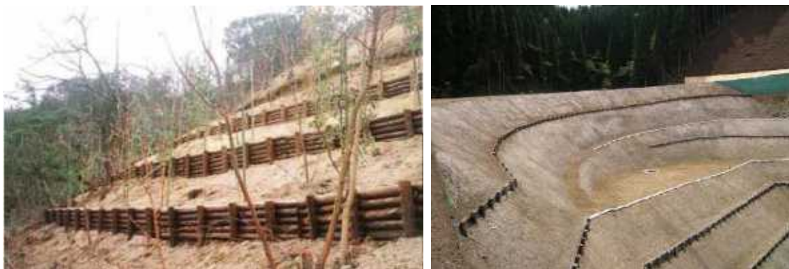
写真 小型木製構造物の例（左：木柵工、右：丸太筋工） 出典：公共土木工事における木材利用事例集
