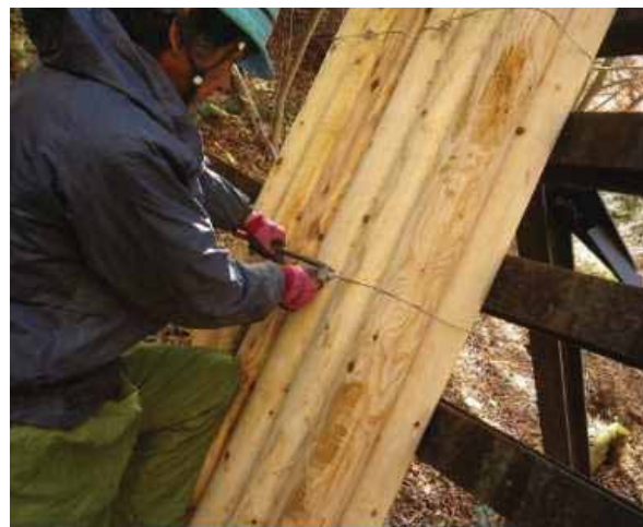
《施工状況（交換）》
