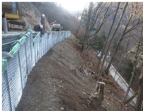
【④防護柵撤去完了（林内への土砂流出なし）】
