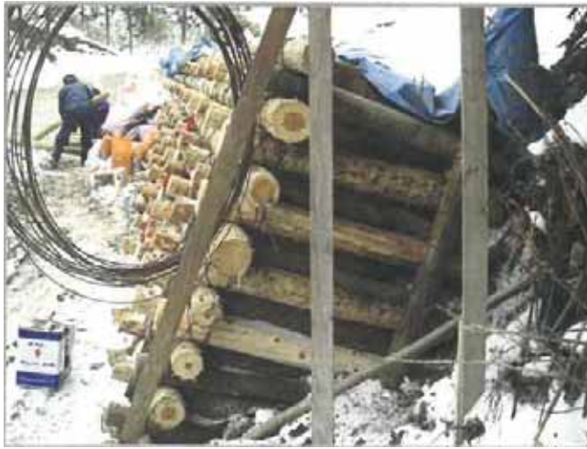
端部施工状況
