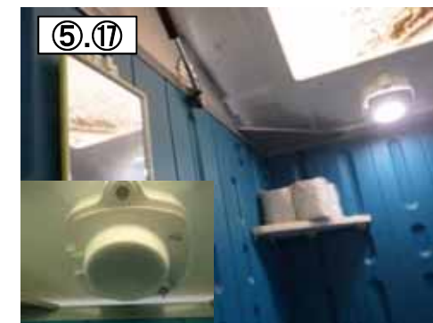
照明設備・小物置き場等
