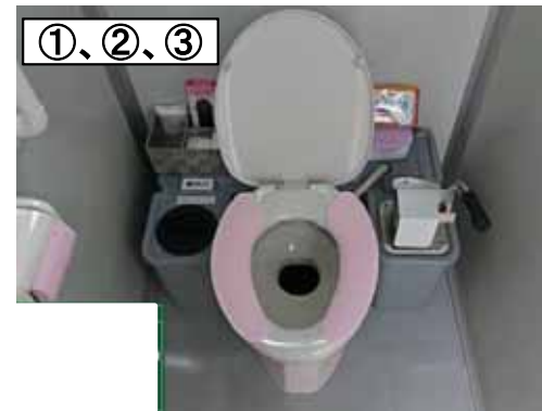
簡易水洗洋式トイレ 臭い逆流防止装置付き
