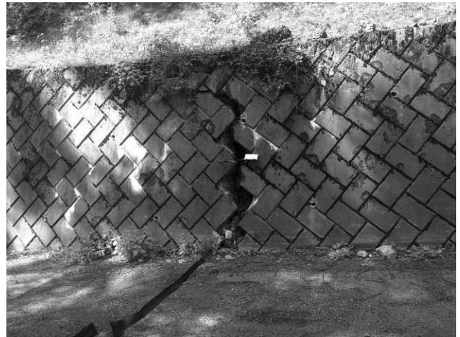
写真 3-2-2 地すべりにより変形した道路施設
