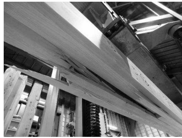
No. 3 : 曲げ破壊（下面）
