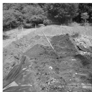
写真-7 防草シートの上 に土を載せる
