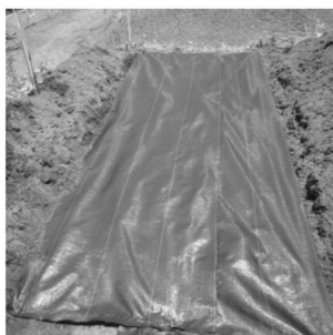
写真-6 防草シートを敷く
