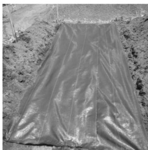
写真-6 防草シートを敷く
