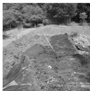
写真-7 防草シートの上 に土を載せる
