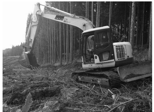
写真-1 走行試験に用いた車両機械
