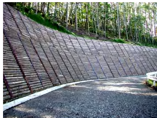
写真-3.1 木製法面工法の様子
