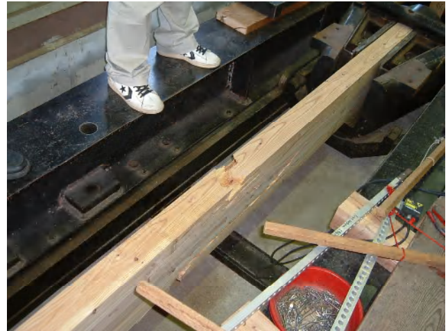
写真 3-3 集成材の引張り破壊
