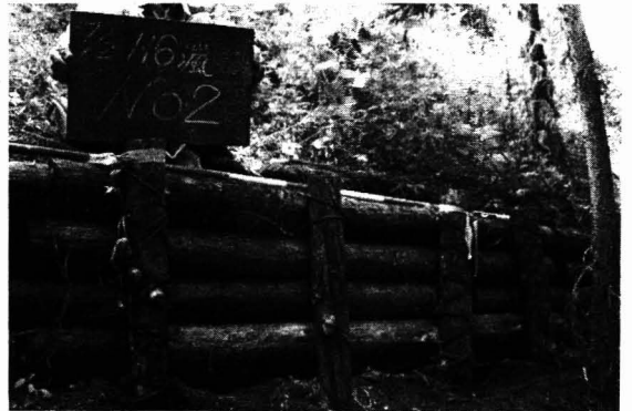
写真-8 現場の例 (9 年経過)
