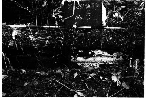
写真-7 現場の例 (17 年経過)
