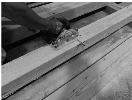
写真-1 背割り作業状況
