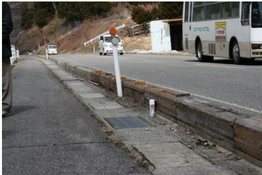
写真-1 試験体 No. 1-3 の施工現場（上）と取り外した部材（右、下面を上にして撮影）
