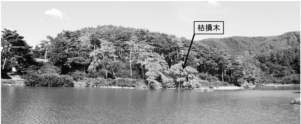
写真 現地確認状況（松本市千鹿頭池）
