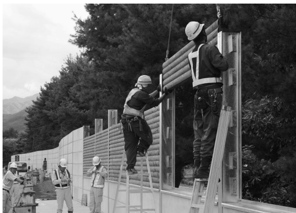
写真-1 2102年のカラマツ製遮音壁の施工
