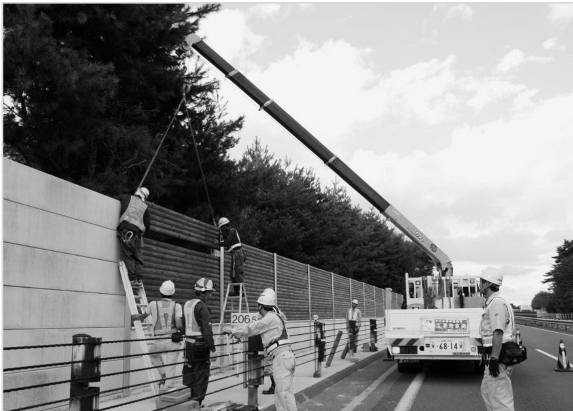
2012年のカラマツ製遮音壁の新設 一県内では27年ぶりー (詳細は本技術情報内に記載)
