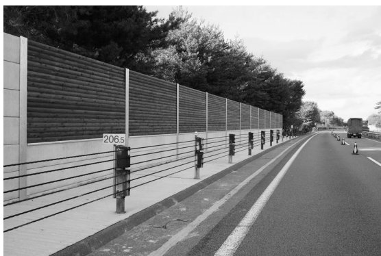
写真-2 完成した2102年のカラマツ製遮音壁
