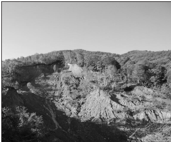
写真-2 2017 年飯山市での災害（崩壊地頭部全景）
