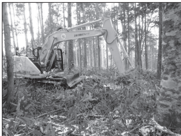
図10 工程調査（従来工法）
