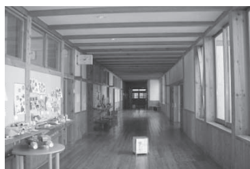
写真-8 カラマツ心持ち構造材 を使用した和田小学校(H12)
