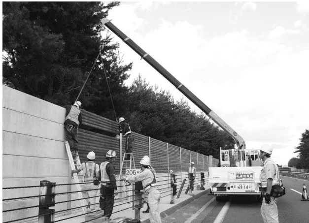
写真-6 2012年度のカラマツ製遮音板の施工
