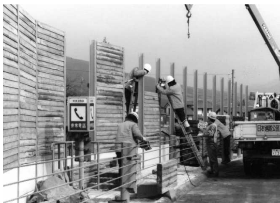
写真-1 1985年度末の遮音壁の試験施工
