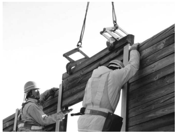
写真-3 カラマツ製遮音板の交換
