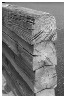
写真-4 20年経過時の最上段の木製遮音板断面 （左）とカラマツ製部材表面の割れ（右）
