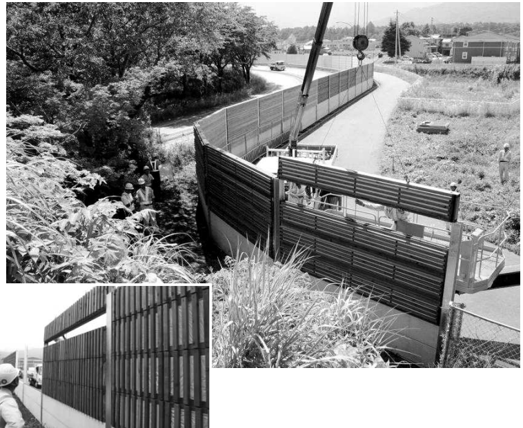
写真-7 2014年度の試験施工（総延長64m）
