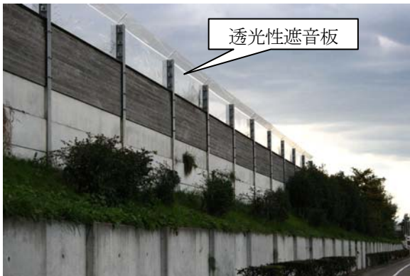
写真-2 群馬県におけるスギ製遮音板と透光性遮音板の併用例（ドライバーの景観対策）
