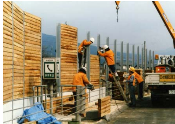
写真-1 カラマツ製遮音壁の試験施工
