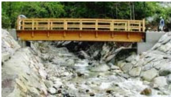
写真-1 炭素繊維補強集成材を使用した歩道橋
