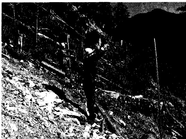
写真-19 柵修理中の様子
