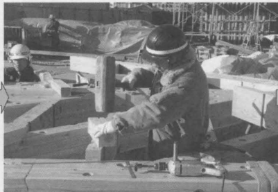
大フレームの組み立て作業
