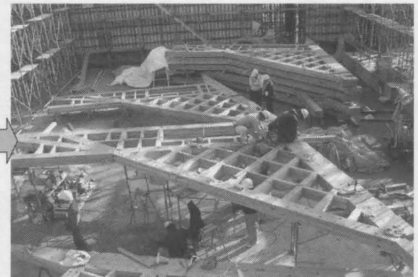
小フレームのボルト締め作業
