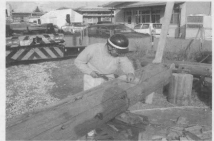
刻み作業（スギ丸太末口径32cm長さ9m）
