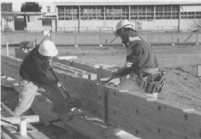
金輪継ぎ手の込み栓打ち
