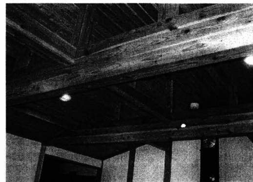
上：全景(ポーチの門柱は9本のカラマツ角材から成る柱、上の梁はトリプルビーム) 下：玄関ロビーのトリプルビーム
