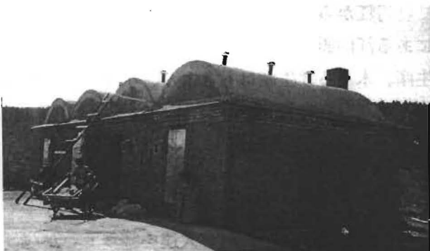
写真-9 煙道式の乾燥装置。
