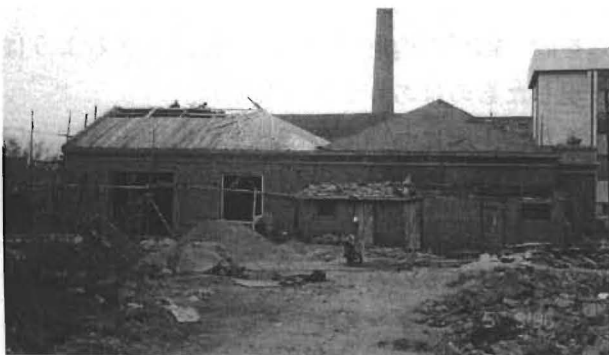
写真-14 小屋組は木材で造られる。 野地板が張られ、この上に防水シートが張られる。
