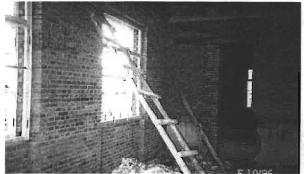
写真-15 窓枠やサッシは木材。-40℃の世界に耐えるため、二重サッシとなる。
