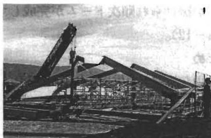
【写真-8】 メインフレームとサブフレームを小梁 でつなぎユニットを組立てる。
