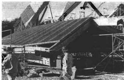
【写真-9】 完成したユニット パネル
