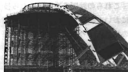
【写真-11】 ユニットパネルの連結 により先端は中央リン グに固定される
