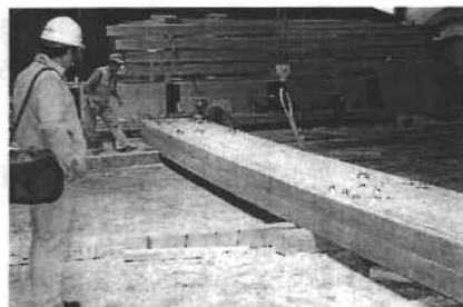
【写真-4】 ドーム用メインフレームの製造 度等級区分機)という機械にかけられ、曲げヤング係数(曲げ剛性)を測定し、これによって強度的に等級区分します。写真-2に示したグレーディングマシンは、現在、我国にあるものとしては最も進んだもので、これにより自動的にヤング係数が測定されます。
