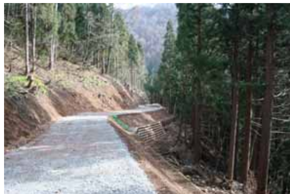
写真 7-16 簡易構造物を用いた林業専用道 火山地帯に配置された林業専用道で、必要最小限の切取、盛土高で構築されているが、部分的に盛土高が大きくなる場合には、丸太構造物を用いて路体の安定確保を図っている。 (中部森林管理局北信森林管理署所管林業専用道)
