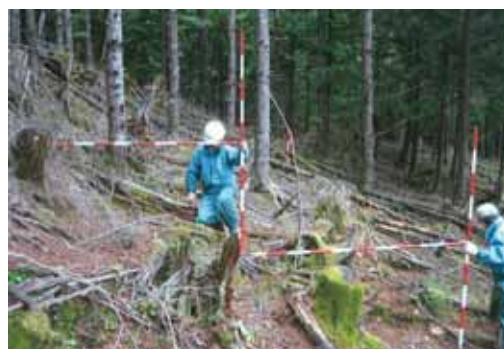
写真 7-20 森林林作業道の横断写真 位置を示すテープの見出し棒（写真中央）と、 中心杭での横断勾配確認作業。
