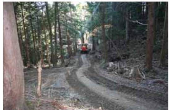
写真 6-6 幹線となる森林作業道 大型（8t級）フォワーダが稼働する幹線。
