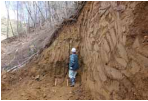
写真 5-11 0次谷頭に到達した路線開設時に発生したクラック（左）と0次谷頭の全景 林道3級相当の森林作業道で、0次谷に到達した時点で路体計画箇所クラックが発生して谷側の土塊がブロック化した。先線計画があったが、山地保全のため開設を中止。掘削断面を埋め戻し、谷側に土留工を施している（右）。
