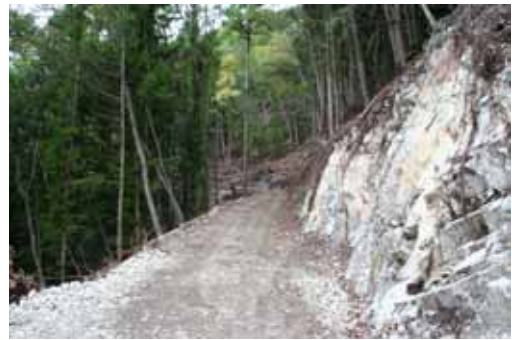
写真 5-10 岩盤が連続する路体構築事例 林道 3 級相当の森林作業道で、硬質岩が連続する。中～古生界付加コンプレックスの白灰岩で流れ盤構造である。
