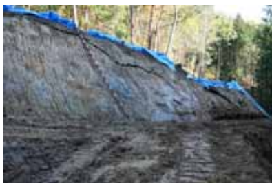
写真 5-13 開設時に変状が発生した法面
