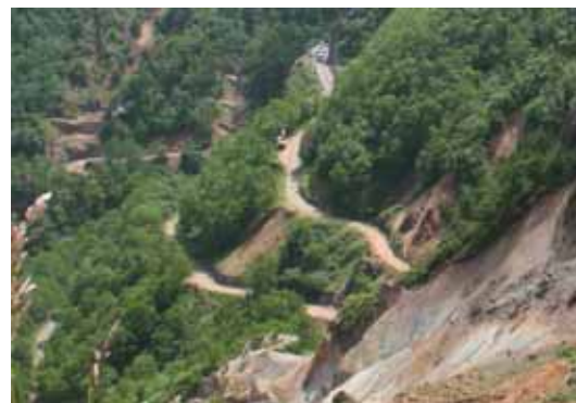
写真 5-18 変質帯を通過する林道 灰白色斜面は熱水変質作用を受けた強酸性土。
