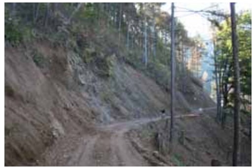
写真 5-9 急峻地形への路体構築事例 林道 3 級相当の森林作業道で、路体構築断面の地山勾配は平均 40 度、この斜面が連続する。
