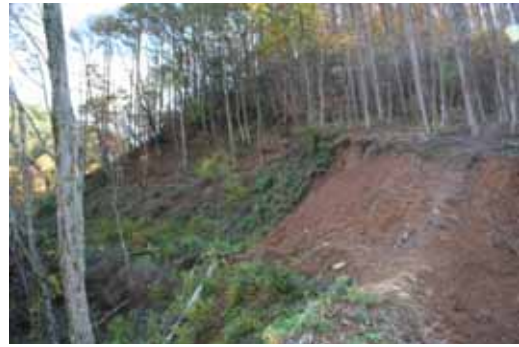
写真 5-11 0次谷頭に到達した路線開設時に発生したクラック（左）と0次谷頭の全景 林道3級相当の森林作業道で、0次谷に到達した時点で路体計画箇所クラックが発生して谷側の土塊がブロック化した。先線計画があったが、山地保全のため開設を中止。掘削断面を埋め戻し、谷側に土留工を施している（右）。
