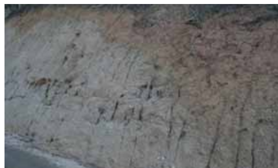
写真 5-19 強風化花崗岩地帯の作業道荒廃状況（左）とマサ土切取面の侵食(右)
