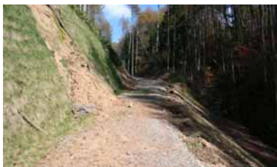
写真 5-19 強風化花崗岩地帯の作業道荒廃状況（左）とマサ土切取面の侵食(右)
