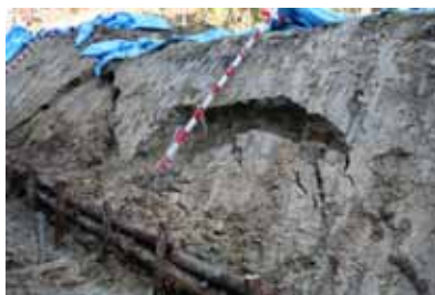
写真 5-13 開設時に変状が発生した法面
