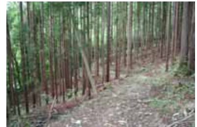
新第三系堆積岩地域の波形線形を用いた森林作業道
