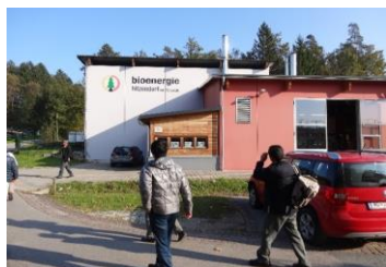
バイオマス地域熱供給プラント
