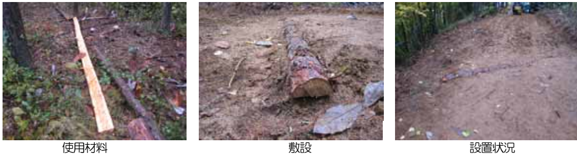
写真 4-32 丸太利用の水切工の設置事例
