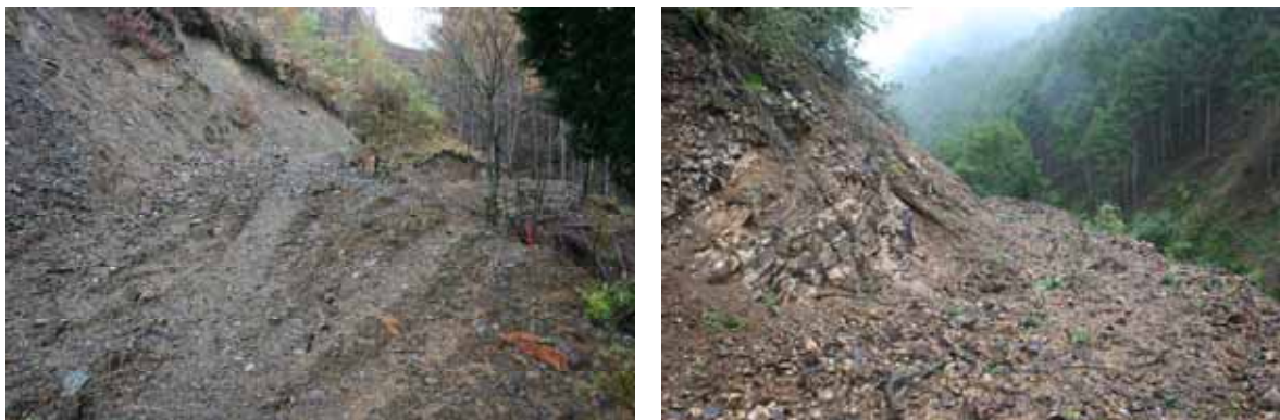
写真 4-20 第三紀砂岩泥岩互層（左）と凝灰岩質の脆弱な岩盤法面
