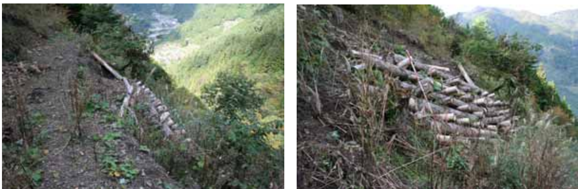
写真 4-46 高さ2m（7段）の丸太積工が破損した事例
