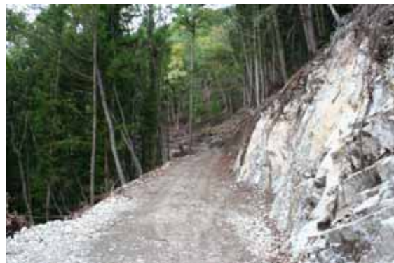
写真 4-16 ブレーカ掘削を行った岩盤
