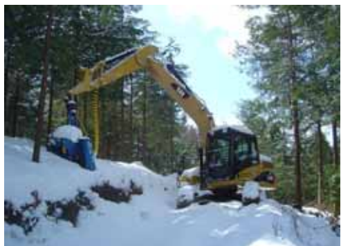
写真 4-4 作業機械の退避 20cm を超す積雪で、作業を中止し、森林作業道の安定した尾根部に退避させたプロセッサ。
