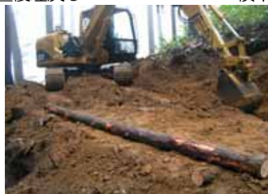
上部縦木設置後埋戻し
