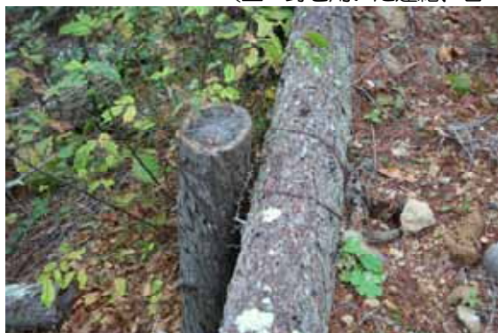
写真4-56 鉄線を用いた1重連結（左：なまし鉄線#10）と鉄筋を差し込んだ事例（右）
