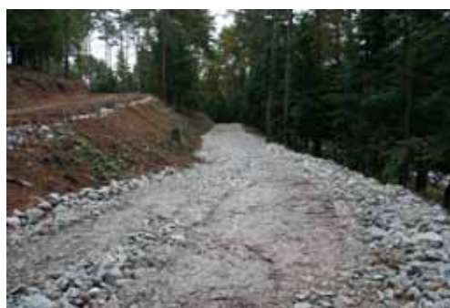
森林作業道に割栗石を全面敷き詰めている事例（左上は森林作業道が分岐する幹線）
