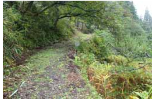
写真 4-57 で構造物に侵入した植生 施工3年後、木本類（スギ）の発生も見られる。構造物下方は畑で手前の植生は畑のミョウガ。
