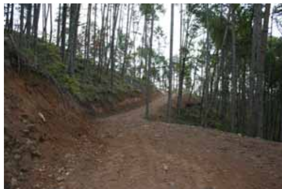
写真2 切取6分、盛土1割2分による路体
