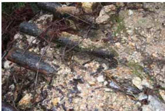
写真 4-62 路面補強丸太が路面侵食を発生させている事例
