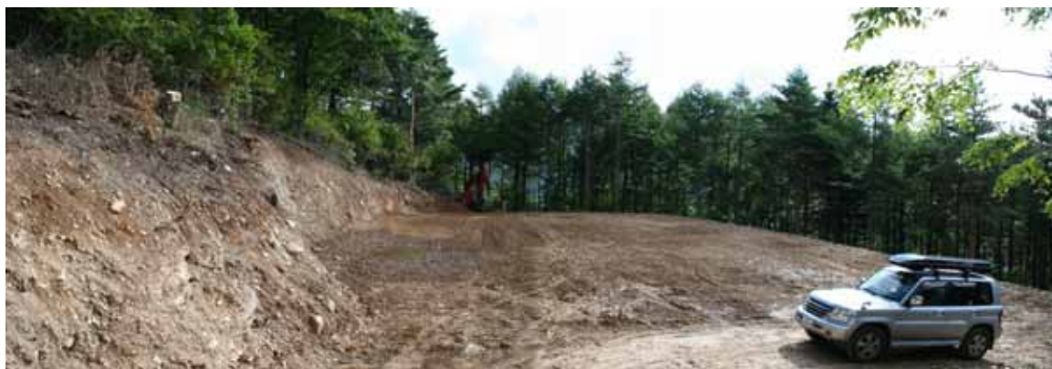
写真1 作業道、森林作業道分岐点に設置した大型トラック積込み用の集積場（面積910㎡）
