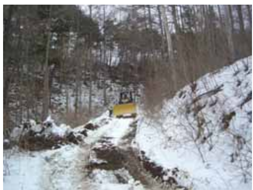
写真 4-3 除雪状況 20cm を超す積雪では、除雪をしても作設作業に支障をきたす。
