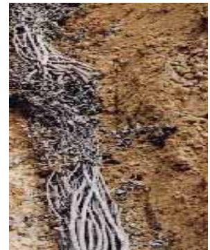
写真 4-36 粗朶暗渠の敷設
