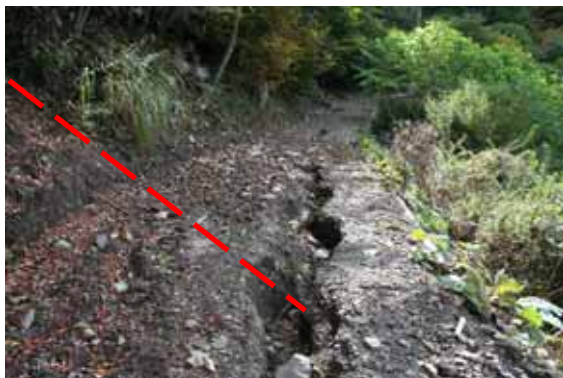
写真 4-51 丸太構造物設置箇所の路肩変状
