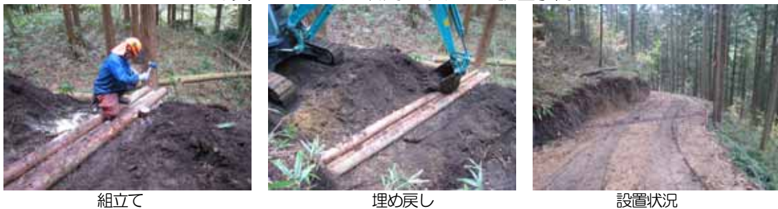
写真 4-32 丸太利用の水切工の設置事例
