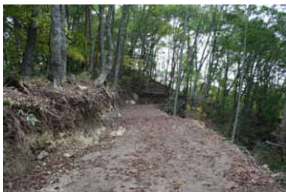
写真1 切取直、表土積工による路体
