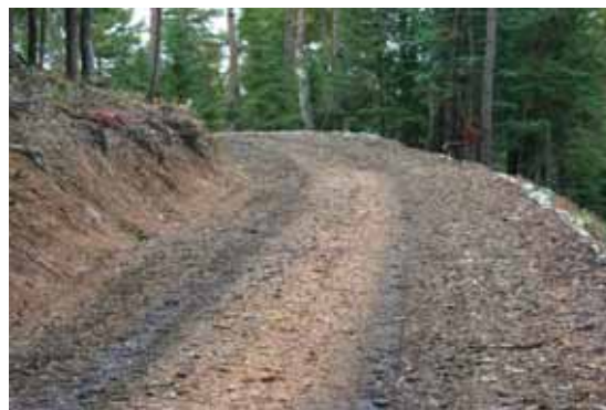
写真 4-63 路面へのチップ敷き事例
