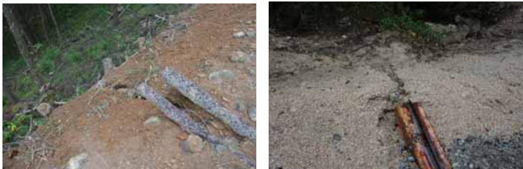
写真 4-35 盛土に設置した水切工による盛土法面の侵食 右は花崗岩マサ土質の盛土法面への路面排水。施工後 1 カ月で侵食が発生した。
