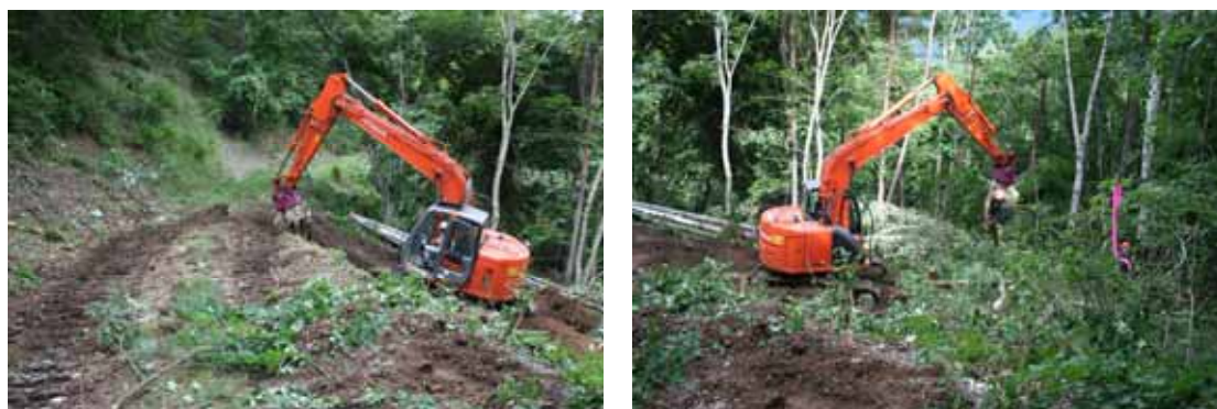
写真 4-10 伐根、伐木を用いた作設状況（0.45 級グラップル機能付きバケット）
