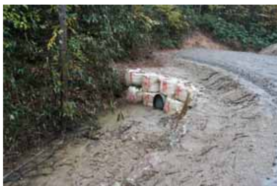
写真 4-59 大型土のう設置事例 事例は路網旧区分の作業道（暗渠呑口）
