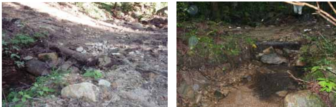
写真4-42 丸太利用洗い越し工の経過（左：作設当初、右：1年後）
