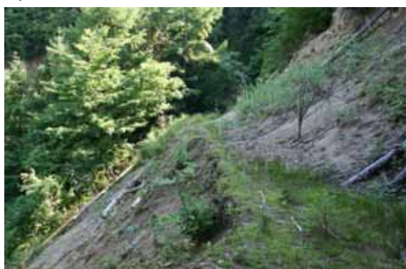
写真 4-18 花崗岩風化土の森林作業道崩壊状況（左）と崩壊全景（右） 崩壊発生箇所は切取法長が長い。
