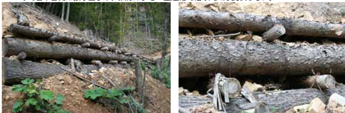
写真 4-54 丸太構造物の中詰め材の状態（礫質土）
