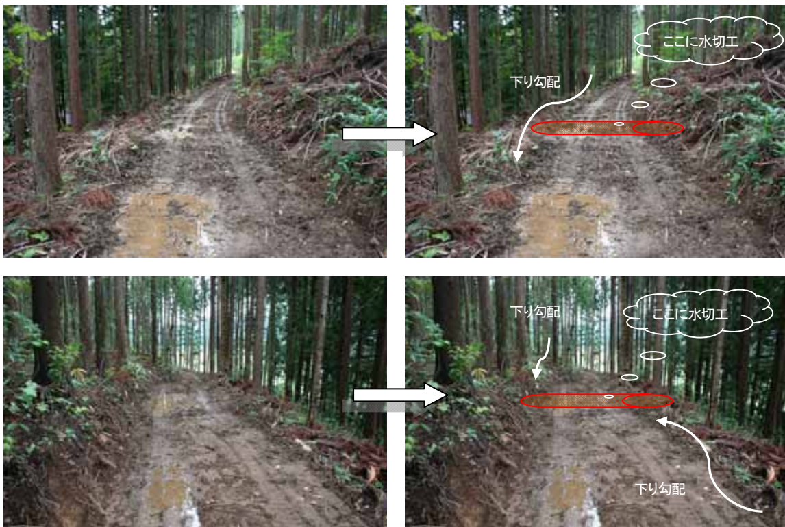
図 4-29 縦断勾配変化点への表面水集中防止対策（滞留防止対策）
