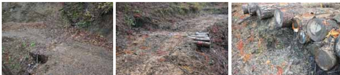
急傾斜地の洗い越し工
