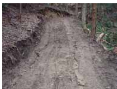
侵食が発生している路面
