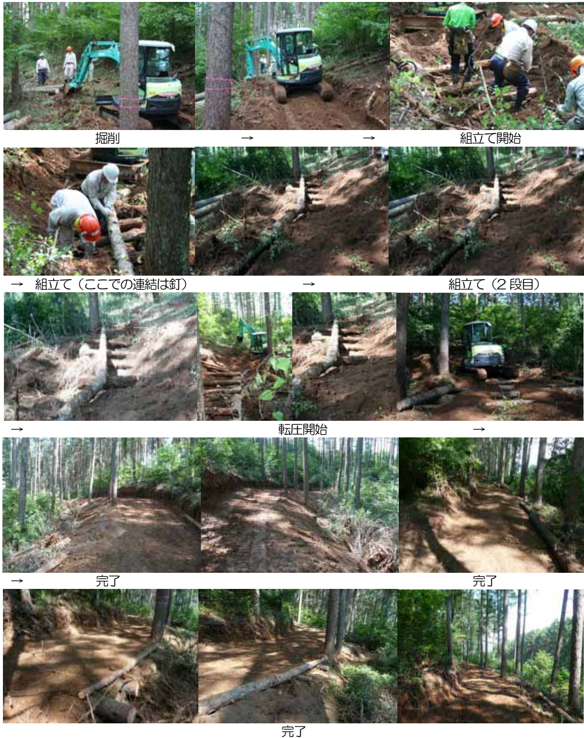
写真 4-47 盛土部路肩の補強丸太構造物の作設の流れ
