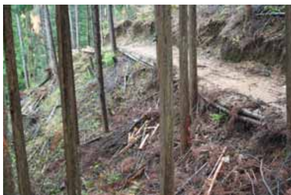
写真-1 旧作業路を改築した路線
