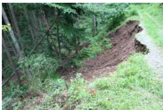
路肩決壊が発生した森林作業道
