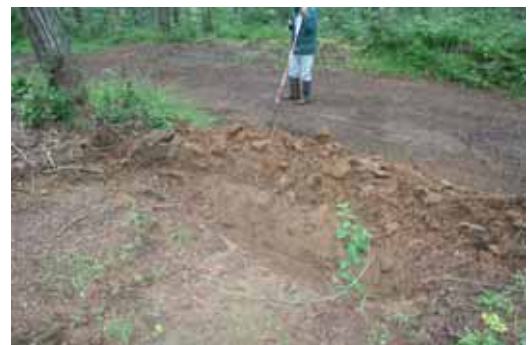
写真3-5 作業路起点の溝（素掘り）進入防止対策
