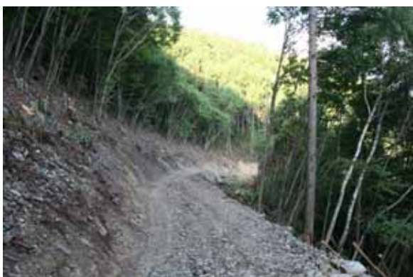
法頭立木の後退伐採（南アルプス破碎帯、崩積斜面）
