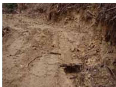
越流水が路面下方に流出
