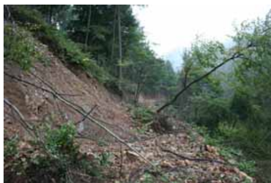
法面崩壊が発生した森林作業道
