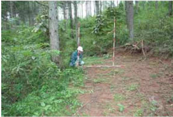
写真 4-28 谷側片勾配による分散排水
