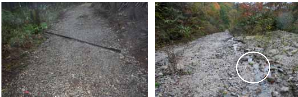
写真4-34 排水効果を発揮しているゴム製水切工（左）と寸不足で路面侵食が発生している水切工（右）
