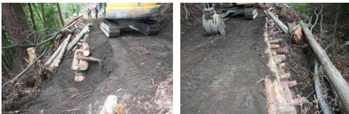
写真 4-53 設置、埋め戻し転圧状況
