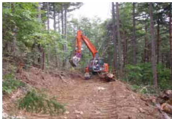
写真4-22 切取法面の仕上げ状況（左：法勾配1：0.6仕上げ、右：低い法面の仕上げ）
