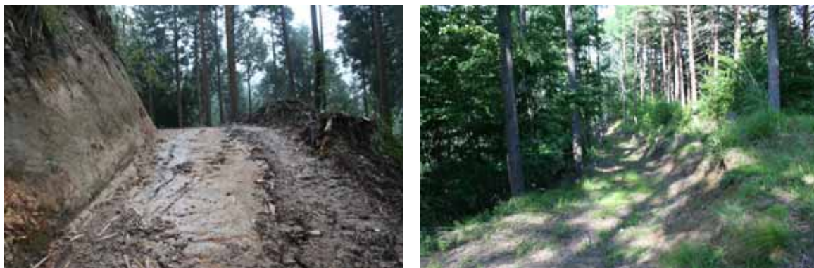
写真 4-19 作設直後の花崗岩（左）と花崗岩風化土地帯で安定している作業路（右） 花崗岩は、均一な法面を整形し易いがマサ化し易い。左の写真では法面はまだ安定しているが、路面に侵食が発生し始めている（施工 1 年以内）。 安定した路体は地山勾配が緩く、切取法長が短い（写真右）。
