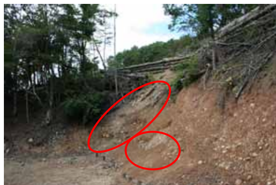
写真 4-17 不安定な堆積土砂部の切取斜面 凹地形には堆積土砂が出現する。このような箇所を大きく切取ると不安定となる。
