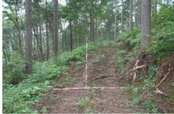
写真 4-29 横断変化点の素掘り排水工
