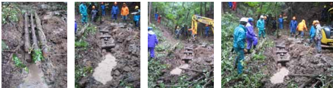
写真4-40 洗い越し工の作設事例
