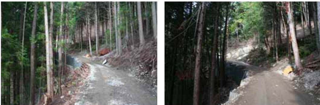
写真 4-58 鋼製L型擁壁が設置された作業道（事例は路網旧区分の作業道）
