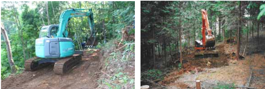
写真 4-23 掘削重機を用いた転圧状況
