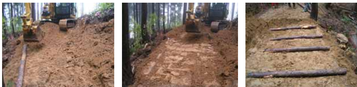
設置基面（路床）整地
