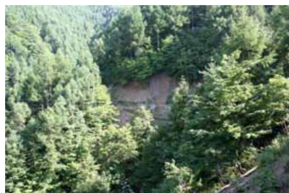
写真 4-18 花崗岩風化土の森林作業道崩壊状況（左）と崩壊全景（右） 崩壊発生箇所は切取法長が長い。
