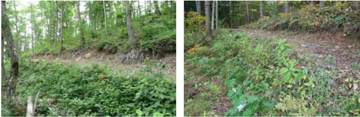
写真 4-25 表土積工の施工事例（施工 1 年後）
