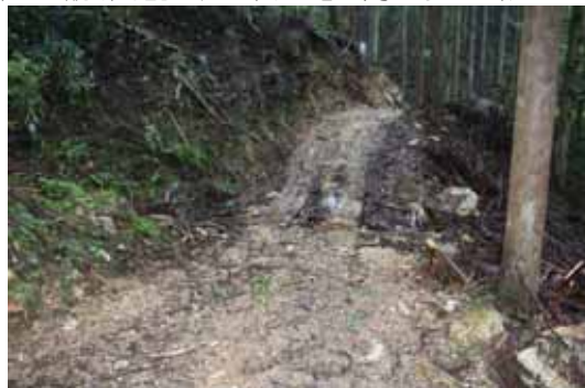
写真4-39 洗い越し工部の縦断勾配事例 通水部を低く、両側を高めになっている。写真手前が下り勾配。
