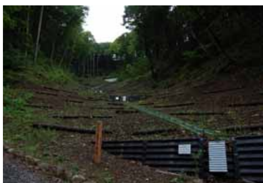
写真4-26 伐木筋工の事例(岡谷市,平成18年7月豪雨災害復旧現場) 左: 伐木筋工の千鳥配置状況、右: 施工3年目の自然散布種子起源のコナラ発芽状況
