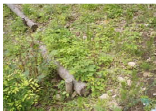
写真4-26 伐木筋工の事例(岡谷市,平成18年7月豪雨災害復旧現場) 左: 伐木筋工の千鳥配置状況、右: 施工3年目の自然散布種子起源のコナラ発芽状況
