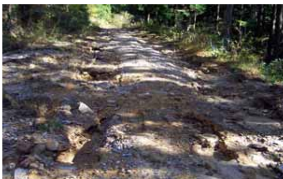
写真 4-27 路面侵食が発生した作業道 左：ガリーの発達した路面、右：地表流の集中流下による路肩結果
