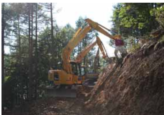
写真4-22 切取法面の仕上げ状況（左：法勾配1：0.6仕上げ、右：低い法面の仕上げ）
