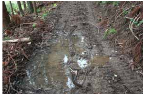
写真 4-30 縦断勾配変化点での滞留事例
