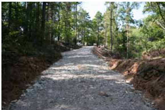
写真 4-61 現場発生材を用いた路面工（左）と碎石（切込み破石・栗石）を用いた路面工（右） 写真右は 12 t 級ハーベスタによる路上作業後。路面の損傷は発生していない。
