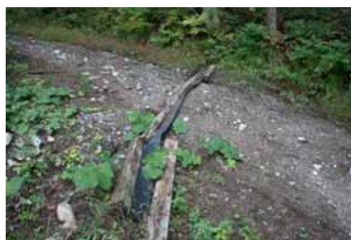
ゴム製水切工の破損 クローラタイプと大型ダンプ 10t 級が走行して破損した。長尺型の抑木を用いないタイプで、荷重がかかる位置に抑木の継ぎ手がある水切工
