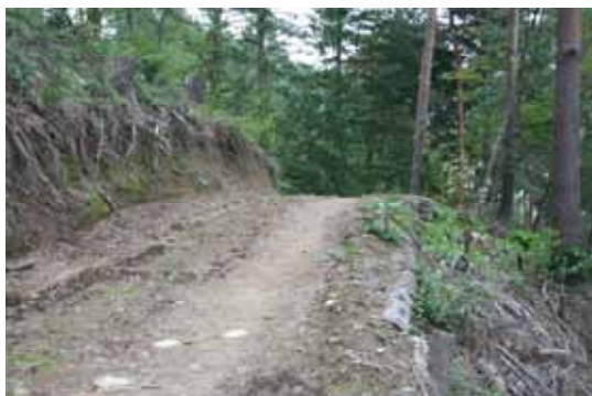
写真 4-64 現場発生丸太による保護路肩
