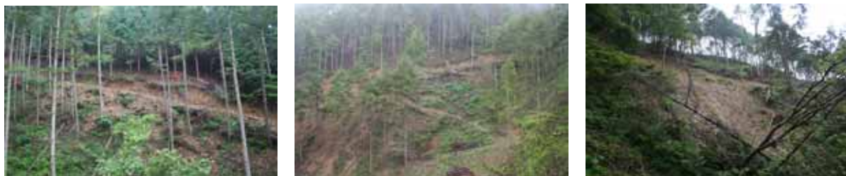
写真4-14 盛溢しの事例（盛溢しによって林地荒廃が発生してしまった現場）
