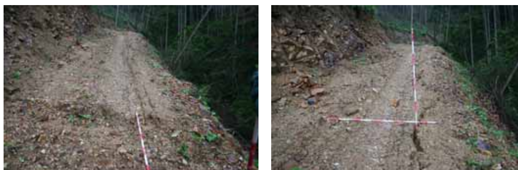
写真.2 谷側の路体にクラックが連続して発生した森林作業道
