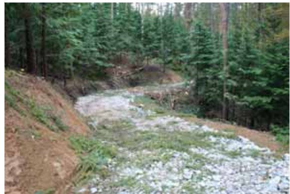
写真 4-61 現場発生材を用いた路面工（左）と碎石（切込み破石・栗石）を用いた路面工（右） 写真右は 12 t 級ハーベスタによる路上作業後。路面の損傷は発生していない。
