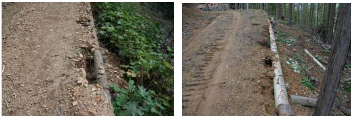
写真 4-52 中詰め土砂の流出による路肩変状
