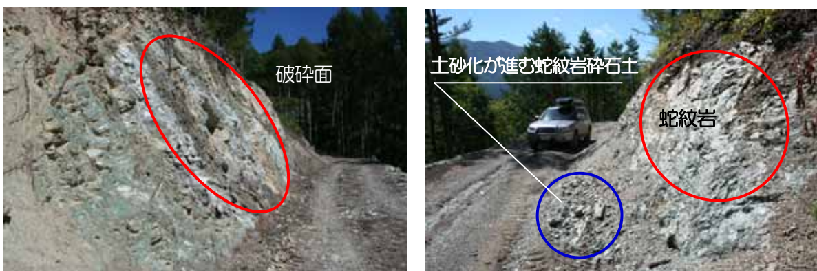
写真 4-21 破碎帯地帯の脆弱な岩盤法面（左）と露頭した蛇紋岩法面（右）
