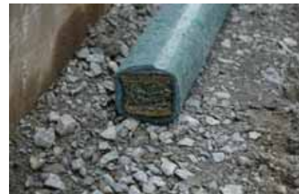
写真 4-38 二次製品の暗渠資材 吸い出し防止材で作られた資材で、粘性土など目詰りしやすい土質に有効。
