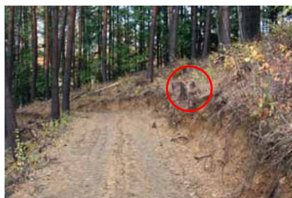
法頭の立木を伐採しても根株を除根しない事例（松本地域）
