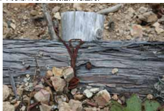
写真4-56 鉄線を用いた1重連結（左：なまし鉄線#10）と鉄筋を差し込んだ事例（右）
