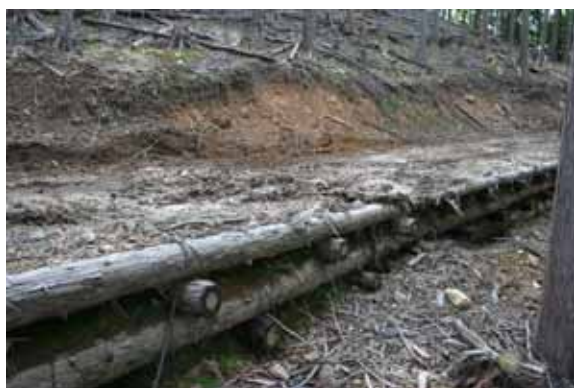
写真 4-50 丸太構造物と路面排水の関係
