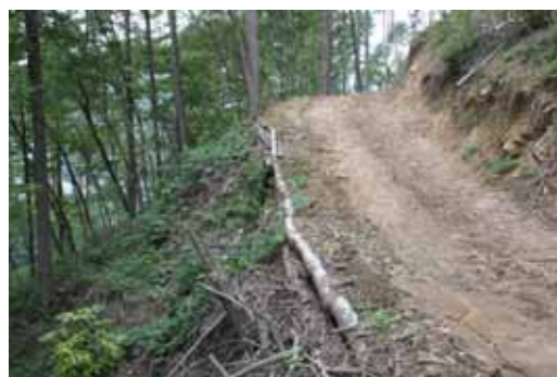
写真4-13 土砂流出対策事例
