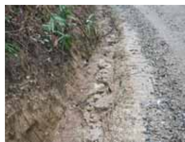
上層路盤工（敷き砂利）をした急勾配の区間は、路面水が走り、侵食を発生させる。森林作業道は、土側溝は作らず、敷き砂利を行う場合は、全幅に敷き詰めることが理想的。
