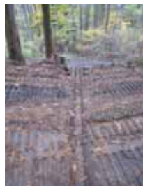
写真 4-33 現場作成水切工（横断溝タイプ）の設置事例
