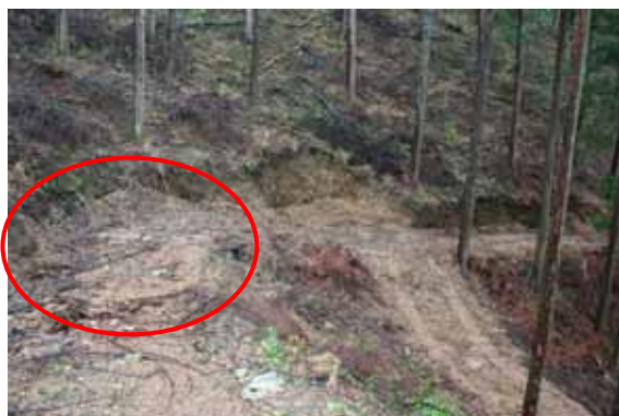
写真 4-17 不安定な堆積土砂部の切取斜面 凹地形には堆積土砂が出現する。このような箇所を大きく切取ると不安定となる。
