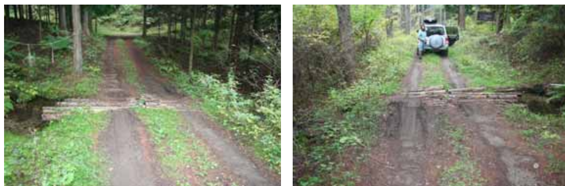
写真4-43 暗渠（ヒューム管φ300）併用型の洗い越し工（暗渠上部に丸太通水路）
