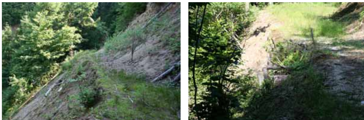
写真 4-48 花崗岩マサ土地の構造物破損状況
