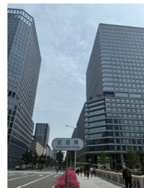
淀屋橋の近くにそびえる、 「淀屋橋ゲートタワー（右）」と 「淀屋橋ステーションワン（左）」
