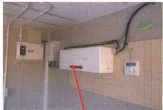
クロスフロー水車・発電機 (上部)
